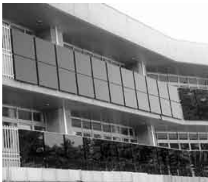
▲飯綱中学校に設置された太陽光パネル
