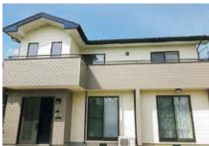
▲外壁と屋根をリフォーム
