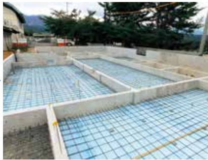
基礎工事(9月下旬) 基礎工事の最終段階にきました。断熱材がはまりました。裸足で過ごしても寒くないよ！
