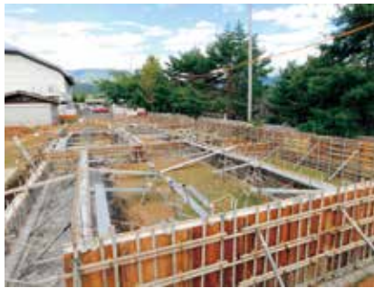
基礎工事(9月上旬) 建物の大きさや、それぞれの部屋の大きさがわかるようになりました。基礎工事はまだ続きます。
