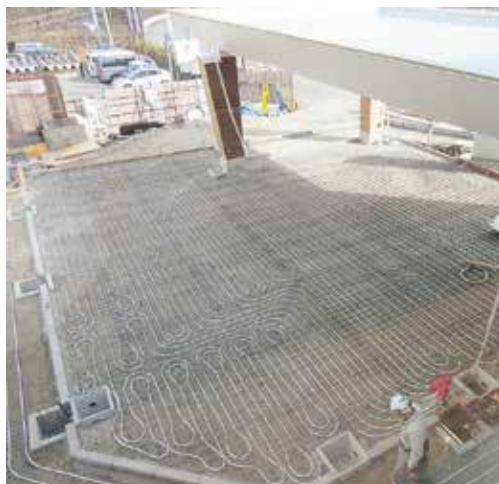
融雪配管の様子
