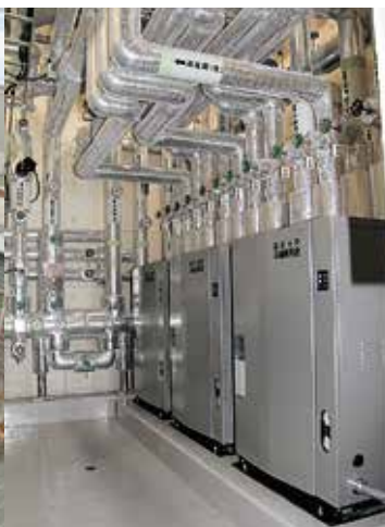
ヒートポンプ
