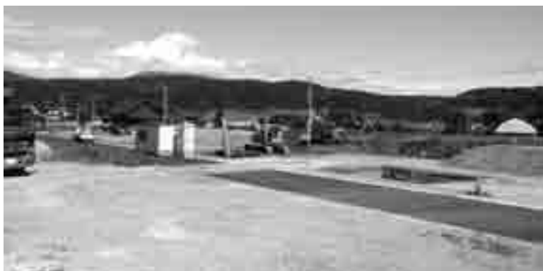
▲黒川の住宅造成地。中央は、町が取得した道路部分
