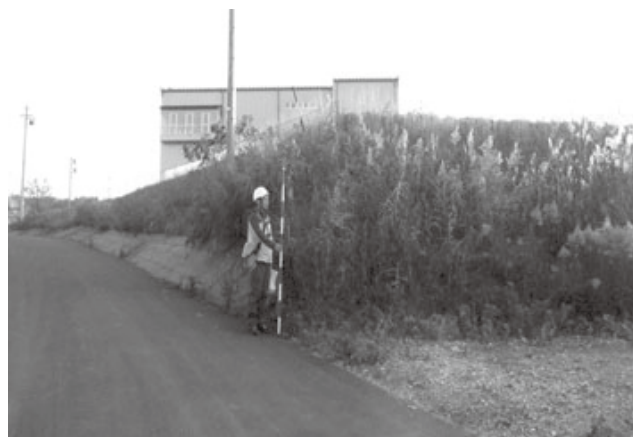
▲盛り土の調査点検が行われた黒川の原因地区造成地
