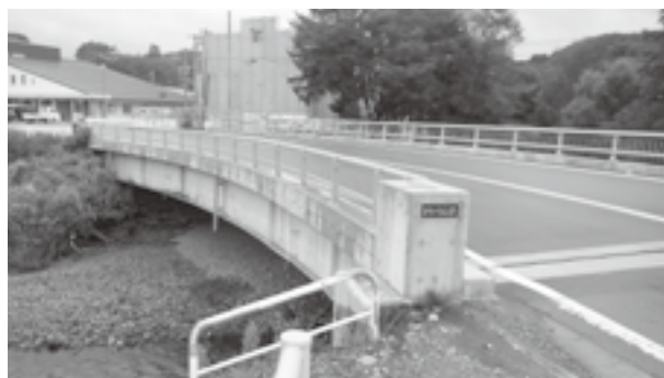
▶メンテナンスが終了した鳥居新橋
