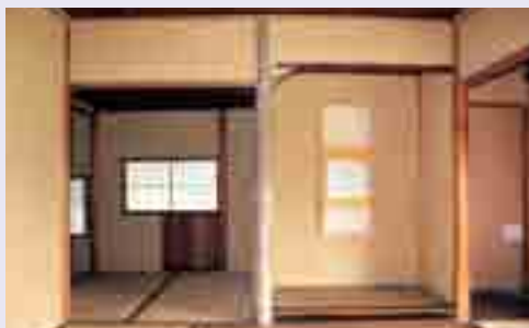
写真上:屋根裏には太い梁が 写真下:室内の様子
