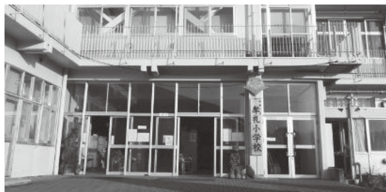
▲正面昇降口の様子
