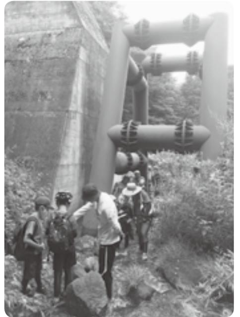
第2砂防ダムの鉄の柱。この鉄の柱が土石流や流木を防ぐ大切な役目をしています。
