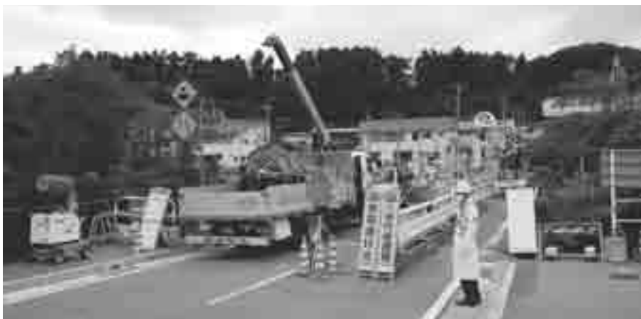
▲華表橋(とりの橋) 歩道設置工事中
