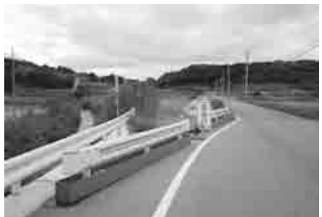
▲牟礼永江線 倉井・赤東 狭隘箇所の幅員整備、歩道の設置等
