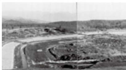
工事中の霊仙寺湖(昭和46年の状況) 『区誌中宿のあゆみ』(2005年発行)より
