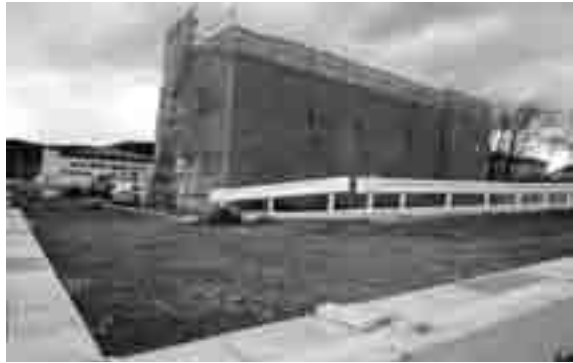
▲造成中の焚荒団地と町道
