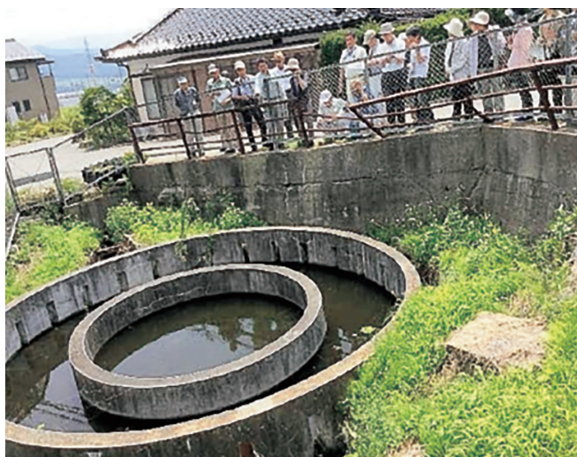
西天竜幹線水路の円筒分水工
