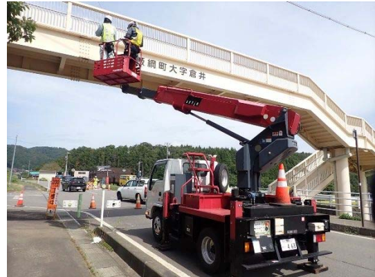
写真 1-2-2 倉井横断歩道橋の点検状況
