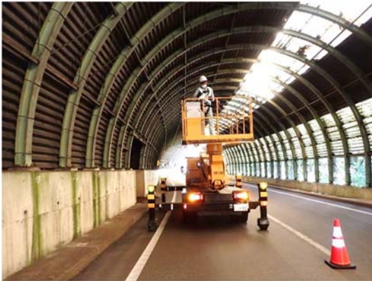
写真 1-2-1 芹沢スノーシェルターの点検状況
