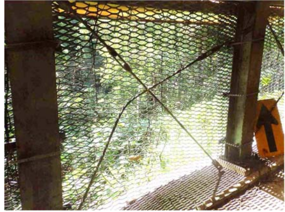
ブレース：変形，脱落（Ⅱ）
