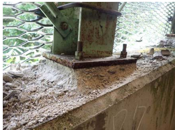
脊座モルタル：欠損(スケリング)（Ⅲ）
