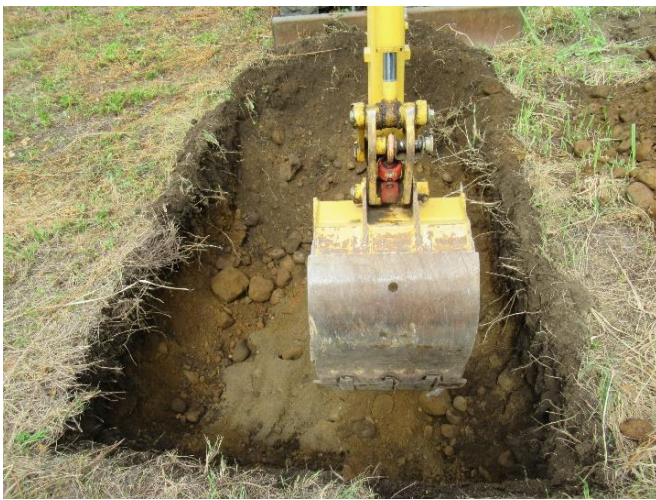
重機掘削のようす
