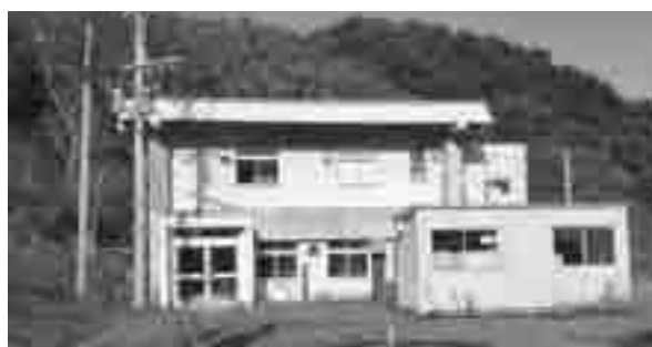
▲移行予定の三水浄水場
