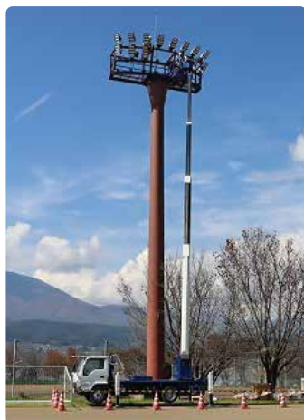
高所作業車での作業は思ったより恐怖を感じた、とのこと。
