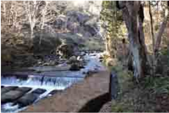
図8 鳥居川峡谷部（図5㉔、普光寺用水取水口付近）
