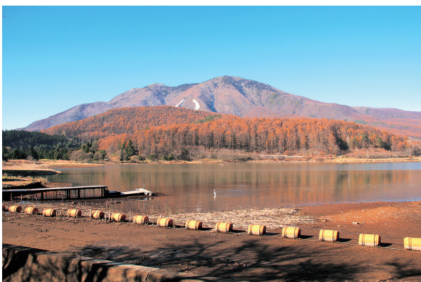
しゅんせつ 霊仙寺湖浚渫工事
