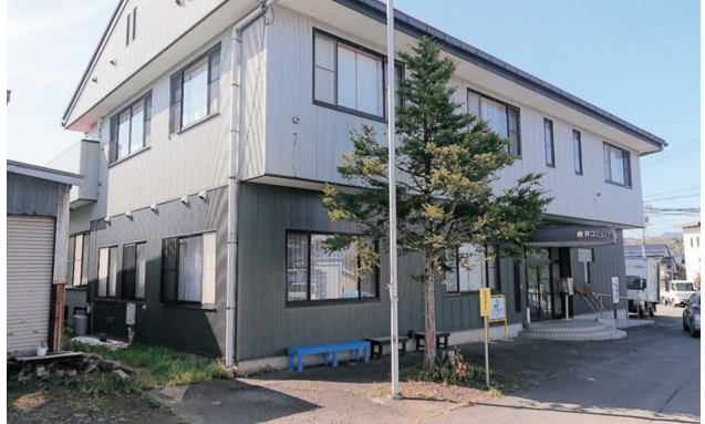
指定避難所に非常用階段を整備します
