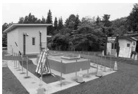
▲進む芋川地籍の土橋水源地工事
