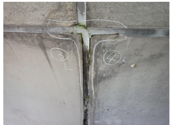
側壁：目地の漏水（Ⅰ）
