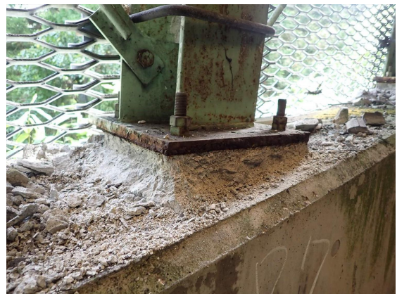
沓座モルタル：欠損(スケリング)（Ⅲ）
