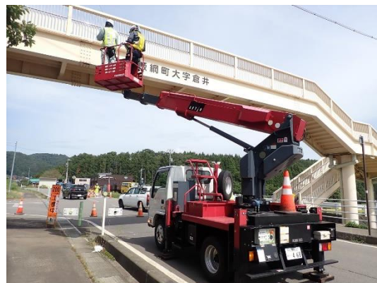
写真 1-2-2 倉井横断歩道橋の点検状況
