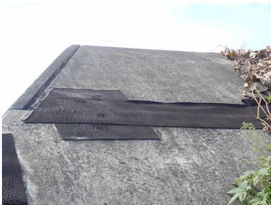
頂版：止水シートの劣化（Ⅰ）
