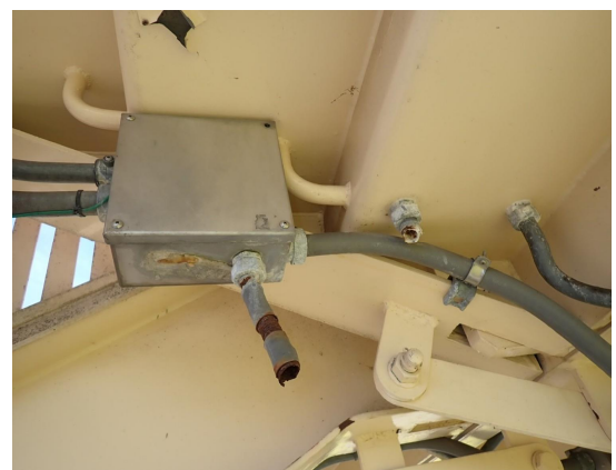
融雪装置：腐食，破損（Ⅱ）
